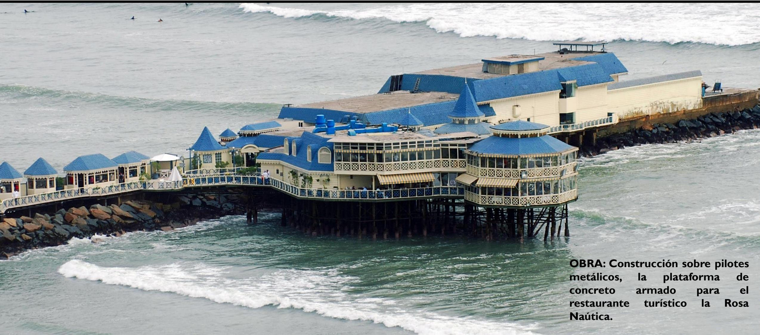
**OBRA:** Construcción sobre pilotes metálicos, la plataforma de concreto armado para el restaurante turístico la Rosa Náutica.
