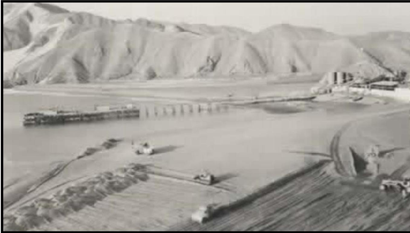
**DESCRIPCIÓN:** Para el Ministerio de Pesquería construcción del Complejo Pesquero de Samanco, compuesto, cámaras frigoríficas, enrocado para encausamiento del río y para protección del área ganada al mar, se construyó un muelle de 180 m de largo por 10 m de ancho con un cabezo de 30 m de ancho por 80 m de largo, provisto de defensas de madera y jebe incorporadas.
